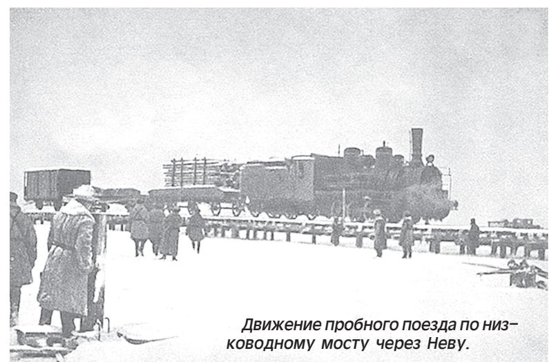
Движение пробного поезда по низководному мосту через Неву.
